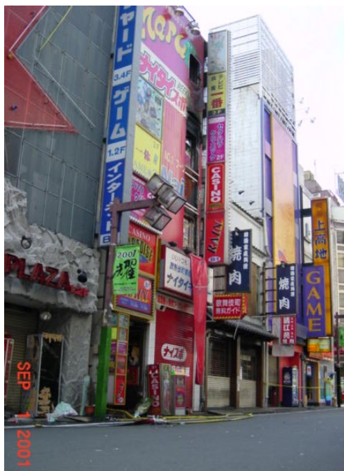
新宿区歌舞伎町ビル火災 平成13年9月1日発生 死者44名 負傷者3名
